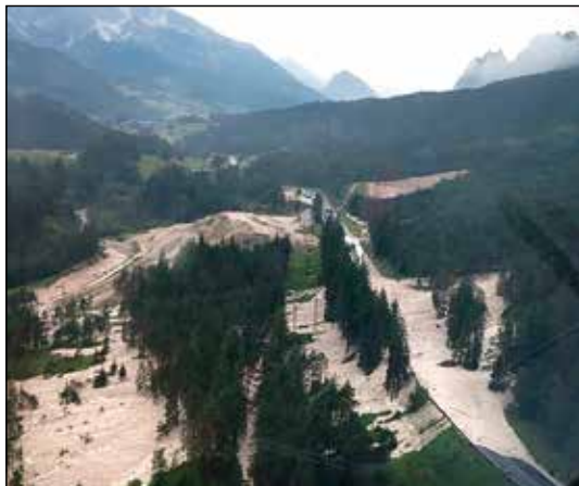
Fig. 19. Una delle interruzioni stradali provocate dalla colata di Piées de ra Mognes nell'estate 2015.
