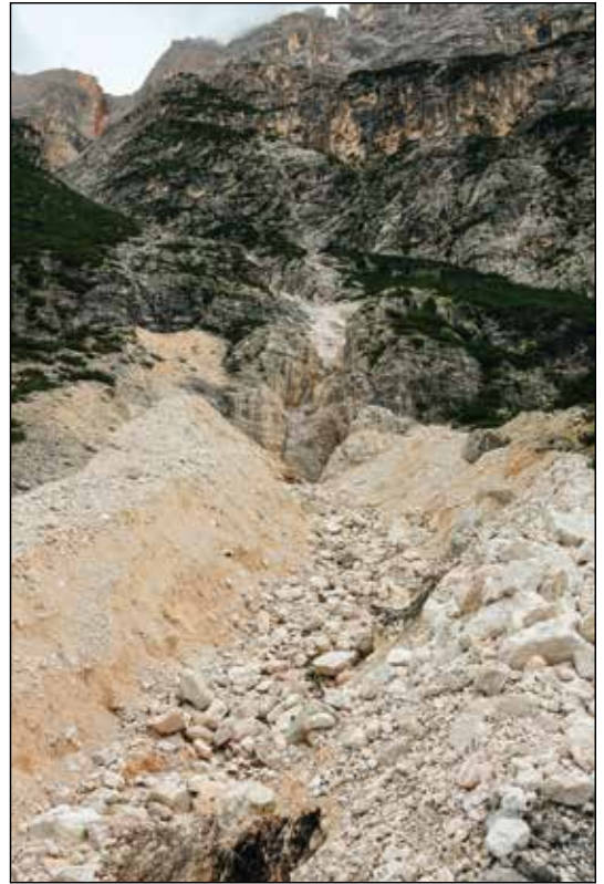
Fig. 18. Il canale di colata immediatamente a valle dello scivolo in roccia Piées de ra Mognes (Agosto 2015).
